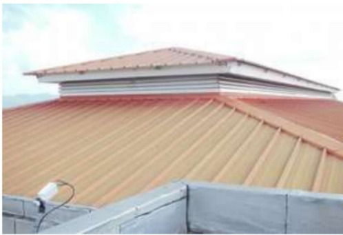
Vue extérieure de la toiture, des combles techniques et du système de ventilation par ventelles fixes
