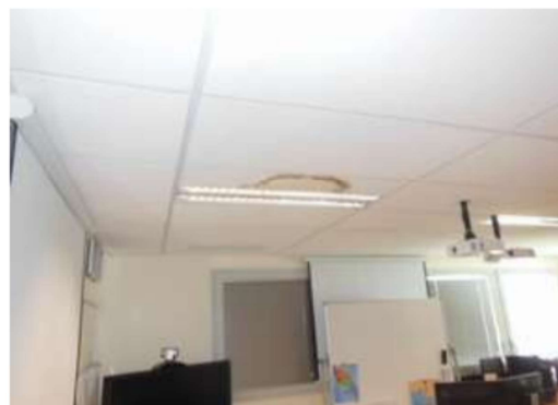
Vue d'une auréole sur plaque de faux-plafond abîmée au niveau d'un luminaire de la salle de décision.
